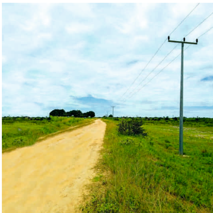
Aproveitamento Hidroeléctrico do Kunje 1 | 30 kV | Angola Client: Grupo ProCme | CME Angola Detailed Design: 2023
