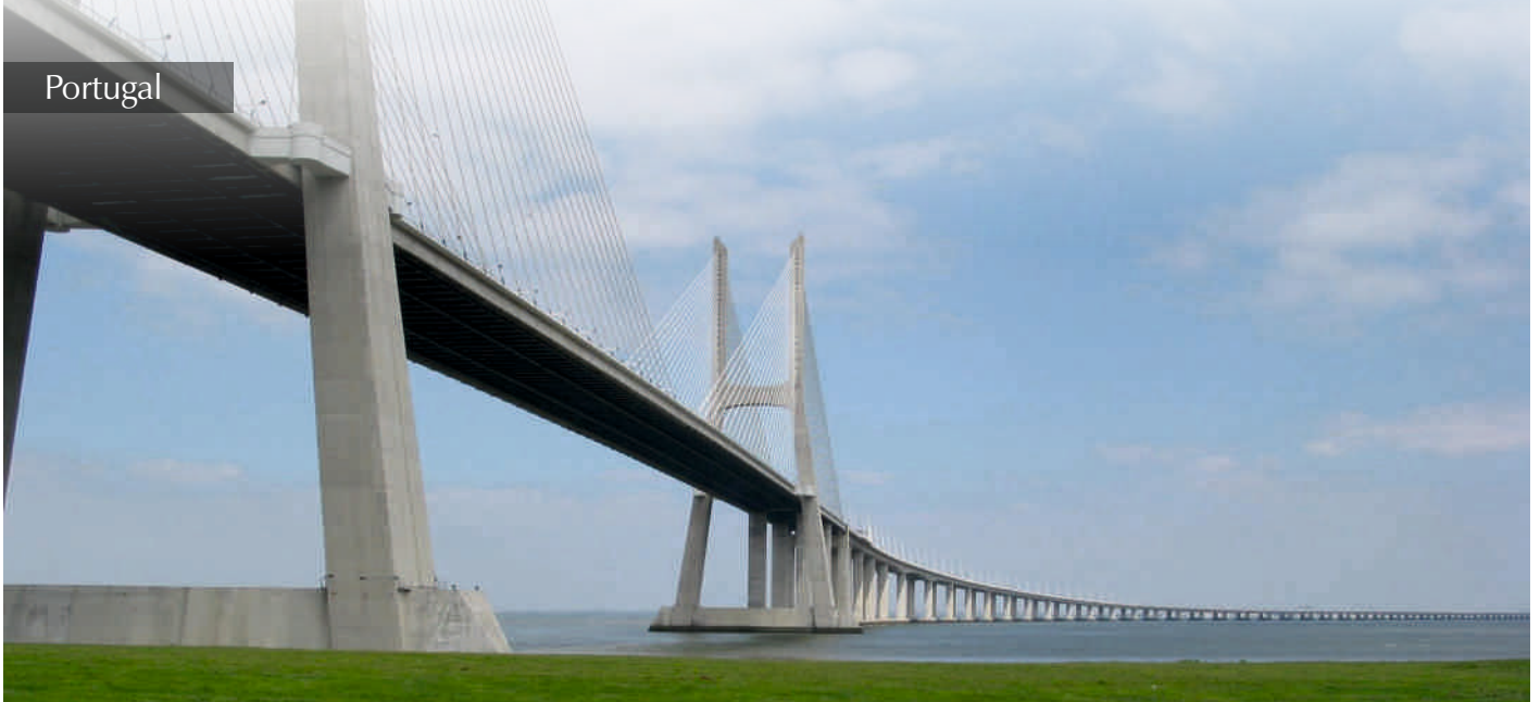
Vasco da Gama Bridge | LUSOPONTE, Concessionária para a Travessia do Tejo, S.A. | Portugal | 1993/94
