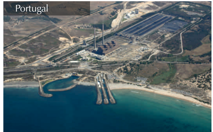
Dredging and Deposition of Sediments from the Water Supply Basin of the Sines Thermoelectric Powerplant. Licensing Studies EDP – Gestão da Produção de Energia, S.A | Portugal | 2006/07
