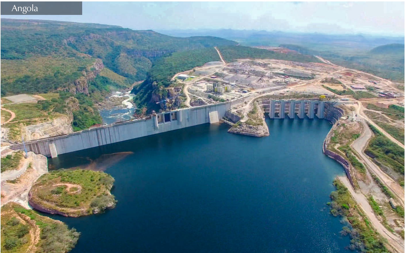
Laúca Hydropower Development | GAMEK – Gabinete de Aproveitamento do Médio Kwanza | Angola | 2014
