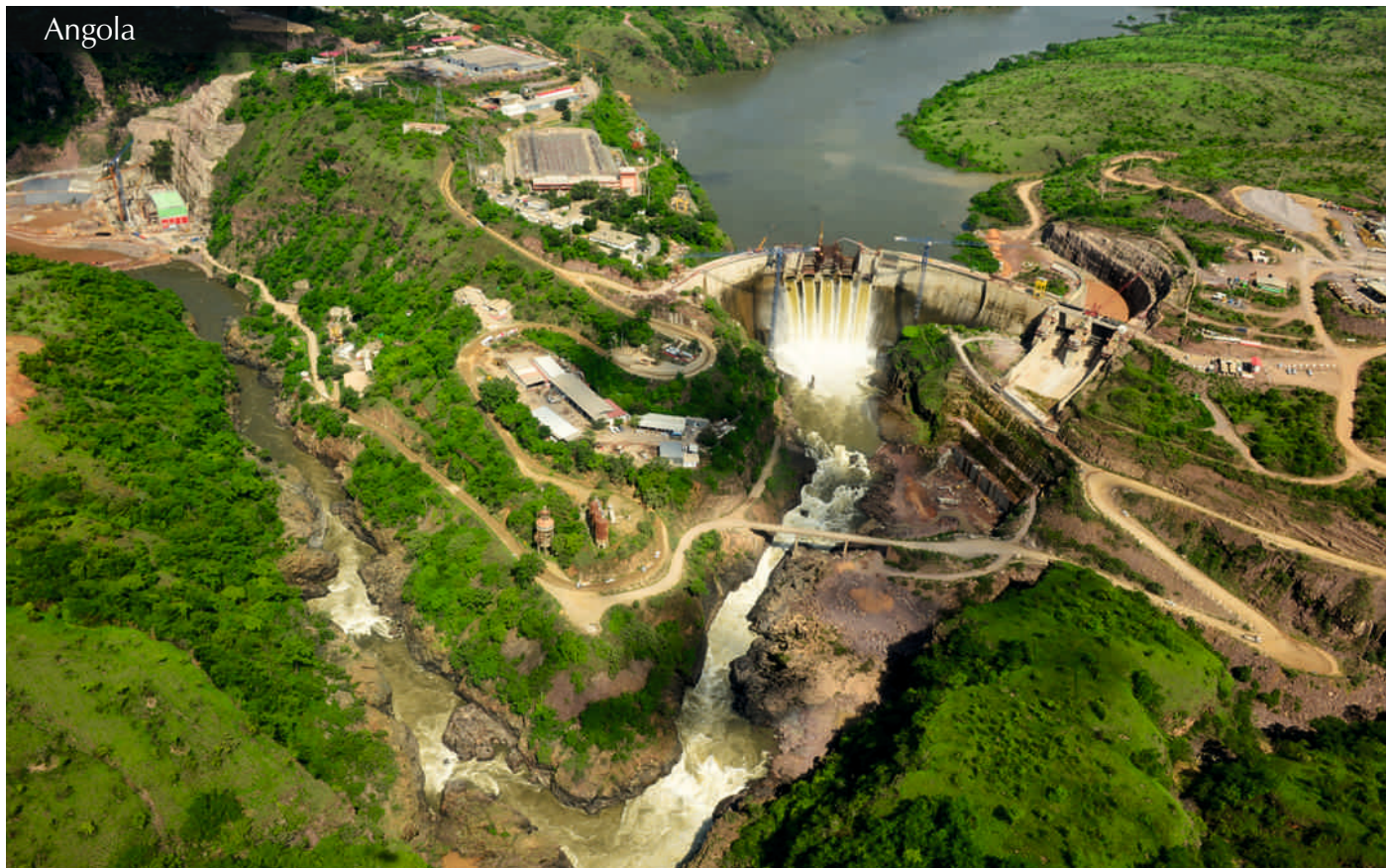
Aproveitamento Hidroelétrico de Cambambe – Central II. Coordenação Geral e Fiscalização de Obras, Acompanhamento/Fiscalização Ambiental da Obra GAMEK – Gabinete de Aproveitamento do Médio Kwanza | Angola | 2014/...
