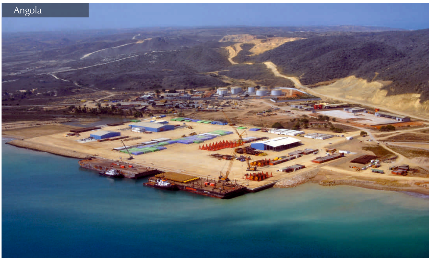
Auditoria ambiental às instalações da PAENAL - Porto Amboim Estaleiros Navais, Lda | PAENAL | Angola | 2014
