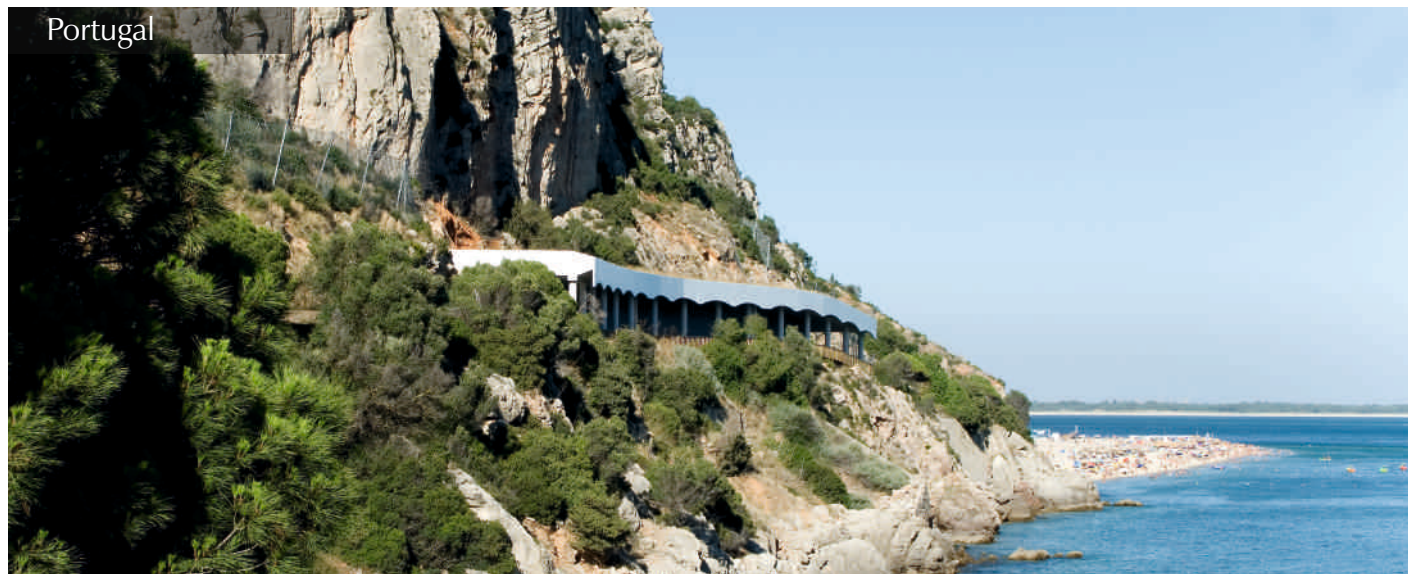
Tratamento e Estabilização das Encostas da EN 379-1 entre Outão e o Portinho da Arrábida | EP – Estradas de Portugal, EPE | Portugal | 2005/06
