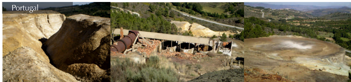
Projeto de recuperação ambiental da antiga área mineira de Santo António de Penedono | EDM – Empresa de Desenvolvimento Mineiro Portugal | 2006/07
