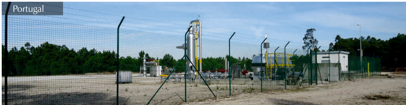
Projeto de construção de três cavidades para armazenamento subterrâneo de gás natural | REN / TRANSGÁS | Portugal | 2011/12
