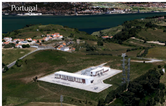
Subestação da Trafaria | REN – Rede Eléctrica Nacional Portugal | 2006/08
